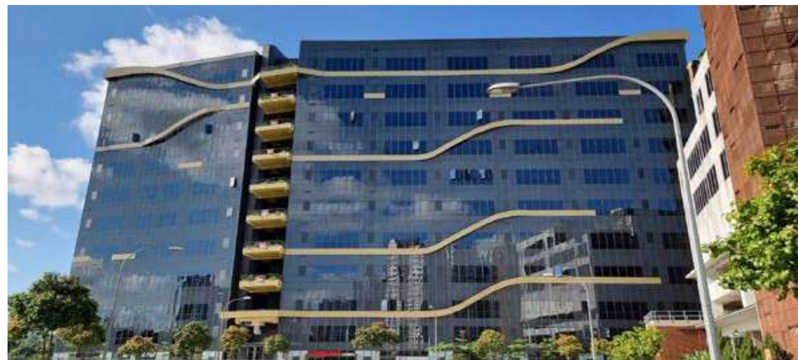
新加坡淡滨尼新月工业园 Tampines Industrial Crescent-1 Singapore
